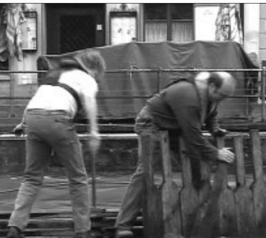
Die Mitarbeiter vom Zimmerwerk müssen schnell handeln
